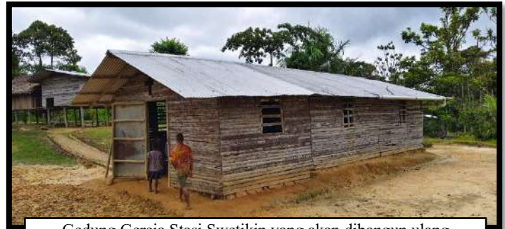
Gedung Gereja Stasi Swetikin yang akan dibangun ulang
